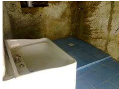
Koupelna je v pískovcové skále. Na snímku v průběhu rekonstrukce
